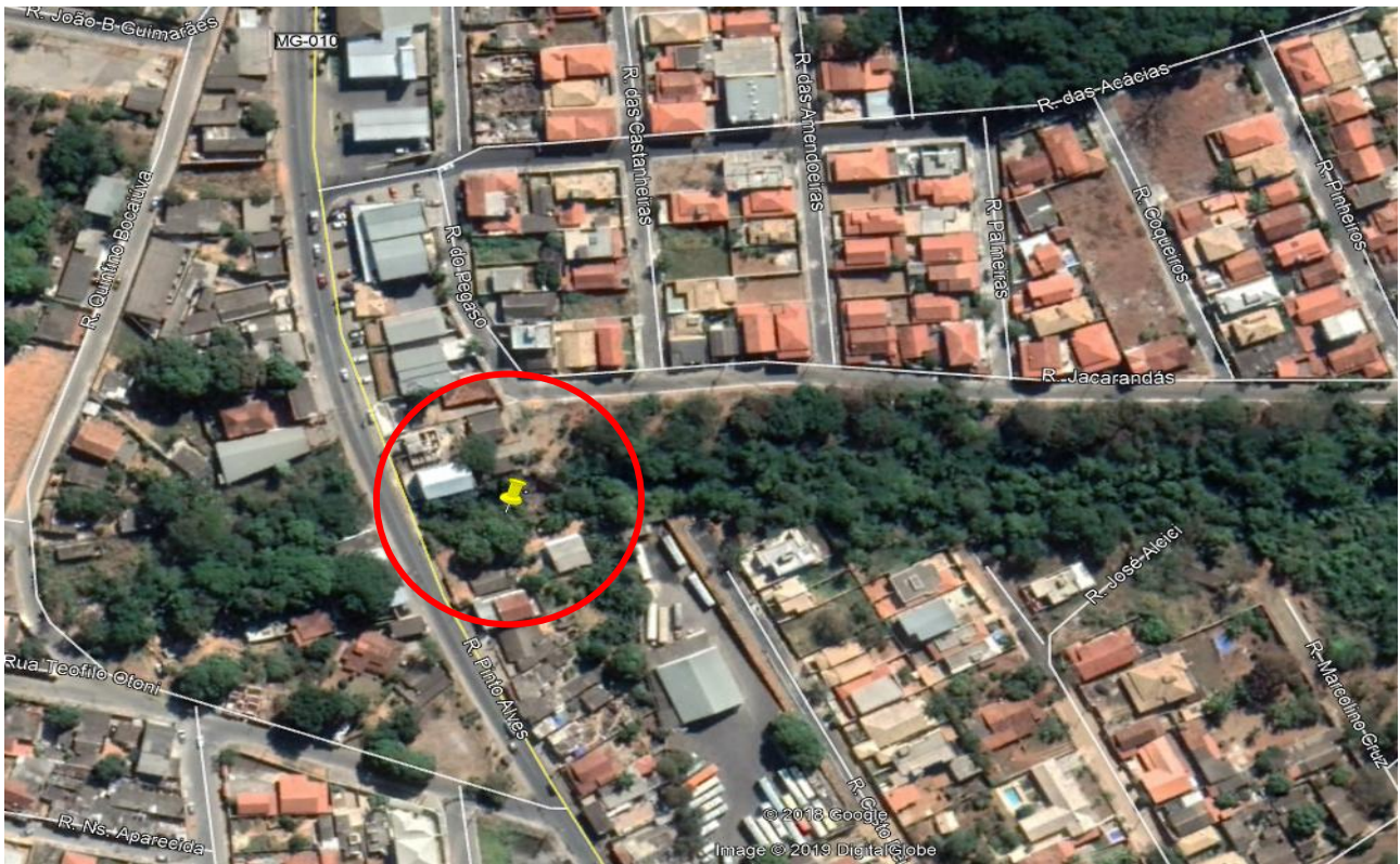
Imagem 1: Vista do local objeto de intervenção.
