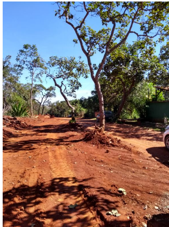
Foto 8: Pequizeiros na área central da via.
