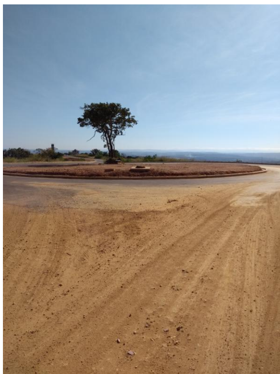
Foto 7: Rotatória onde será finalizada a via.
