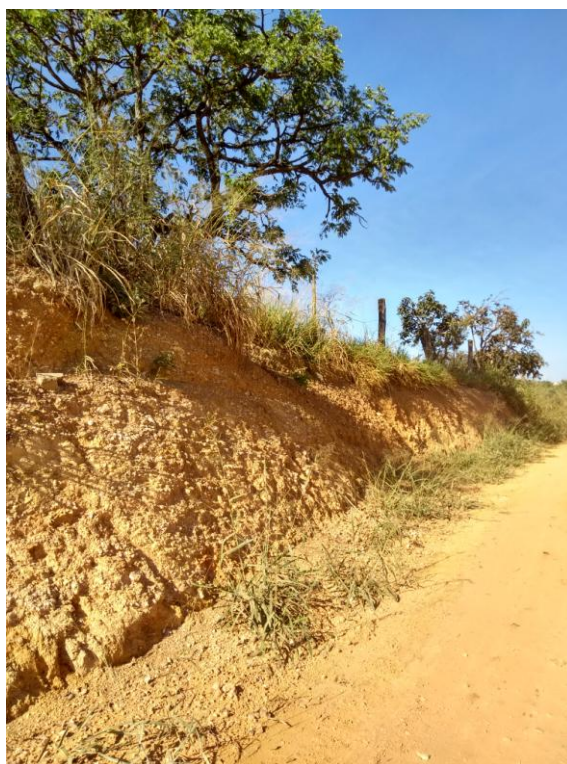
Foto 8: Via já existente próxima à rotatória.
