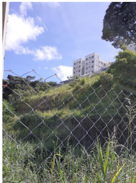
Figura 4 - Caracterização das instalações da ETE Provisória, a ser desativada para a implantação da rede de esgoto com visão do empreendimento ao fundo, antes da manutenção. Fonte: Arquivo DMA
