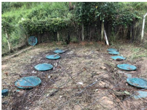
Figura 5 – Caracterização das instalações ETE Provisória, após a manutenção realizada no local.
