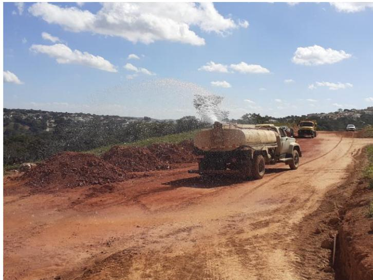
**Imagem 5** - Caminhão pipa realizando a umidificação de vias do empreendimento em implantação. *Fonte: Arquivo DMA*
