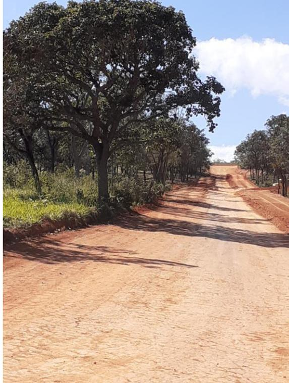
**Imagem 6-** Demonstração de via aberta, apresentando "terra batida" e controle do carreamento de materiais. *Fonte: Arquivo DMA*
