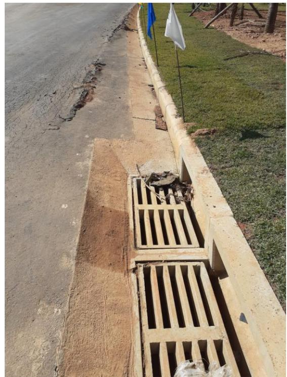
**Imagens 9 e 10** - Dispositivos de drenagem em implantação no loteamento. Boca de lobo dupla implantada no local, com destaque para danos ao pavimento (como a obra ainda não foi finalizada observa-se a necessidade de adequações no local). *Fonte: Arquivo DMA.*
