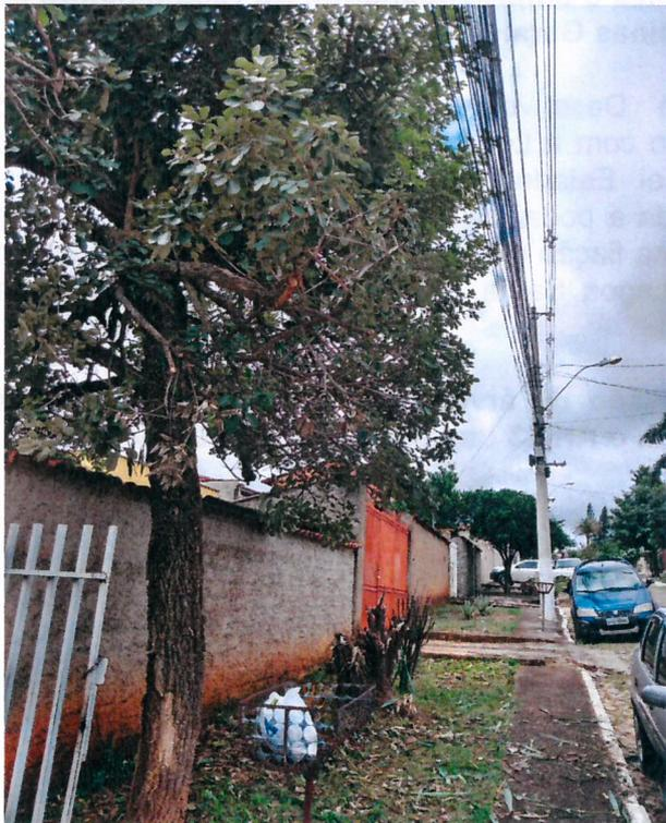
Foto 03: Destaque para proximidade dos galhos na fiação elétrica.
