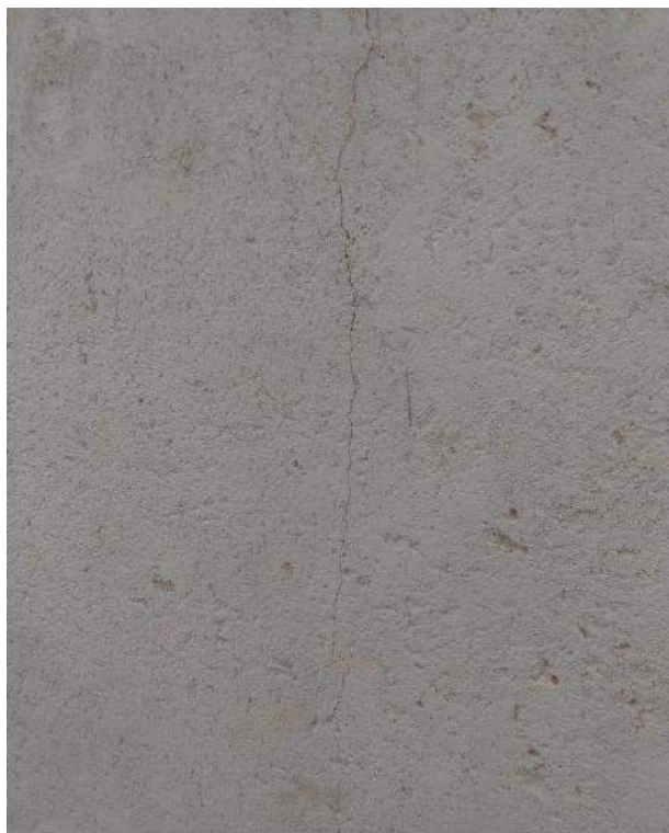
Fotos 05 e 06: Leve trinca longitudinal no muro.
