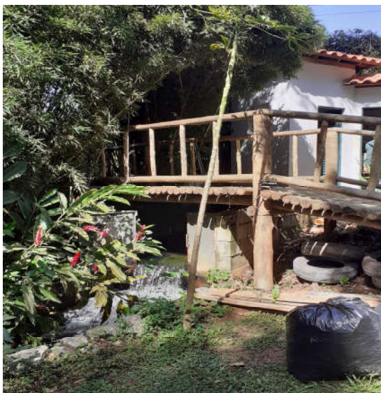
Imagem 2 - Canal de drenagem natural proveniente do extravasamento do barramento do Córrego do Fidalgo, com destaque para as intervenções realizadas pelo condomínio. Fonte: Arquivo DMA.
