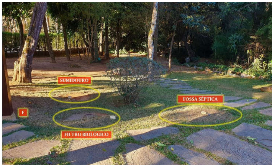
Figura 4 – Localização da fossa implantada no local para atendimento ao banheiro instalado na área de APP. Fonte: Documentos técnicos do processo 6352/2021.
