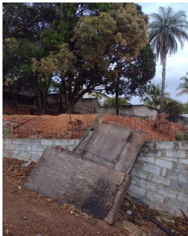
Foto 04: Destaque para o desnível do terreno em relação à via.
