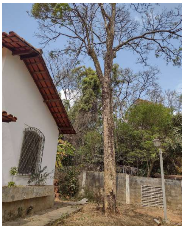
Foto 05: Destaque para proximidade à área construída.
