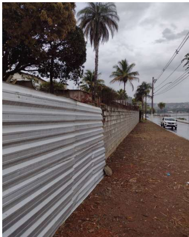
Foto 09: Vista lateral do terreno, margem da lagoa central.
