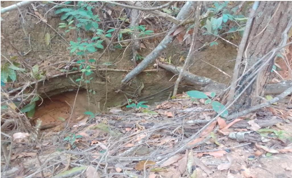
Figura 4: Imagem do canal de drenagem com ausência de escoamento superficial. Fonte: Próprio autor.
