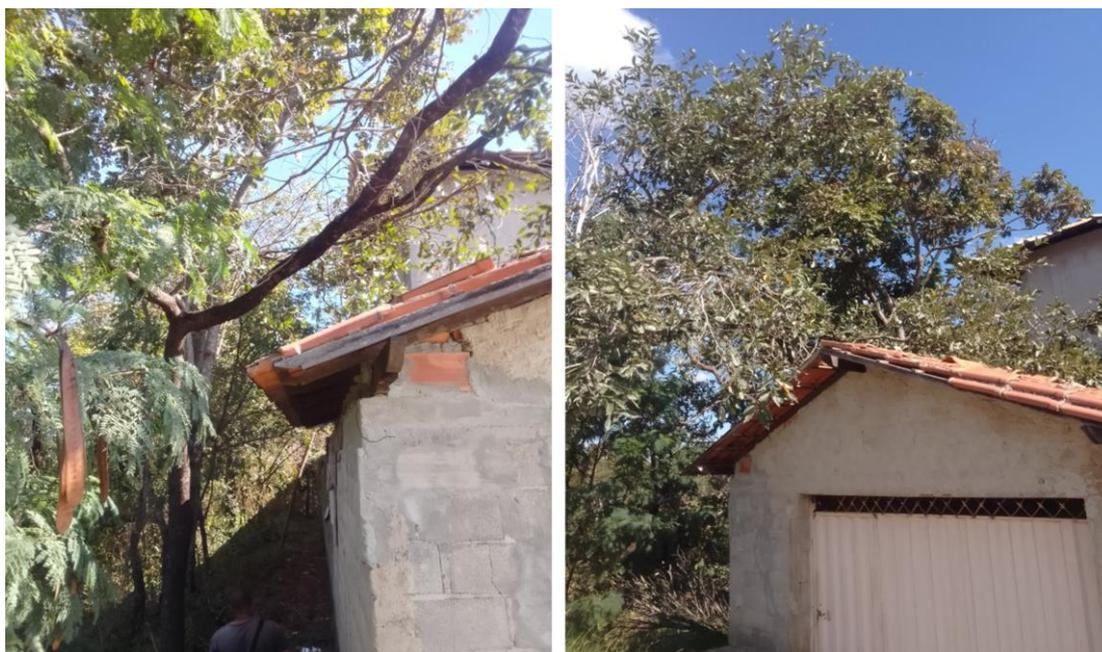
Figura 12: Vegetação sobre o telhado da residência. Fonte: Próprio autor.
