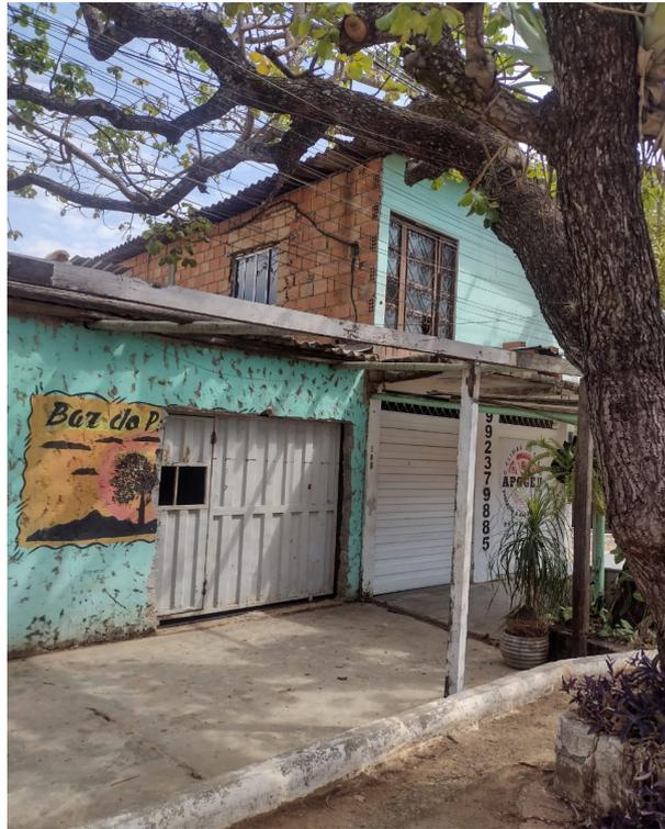
**Foto 05:** Grande galho sobreposto no telhado, com presença de rede elétrica.
