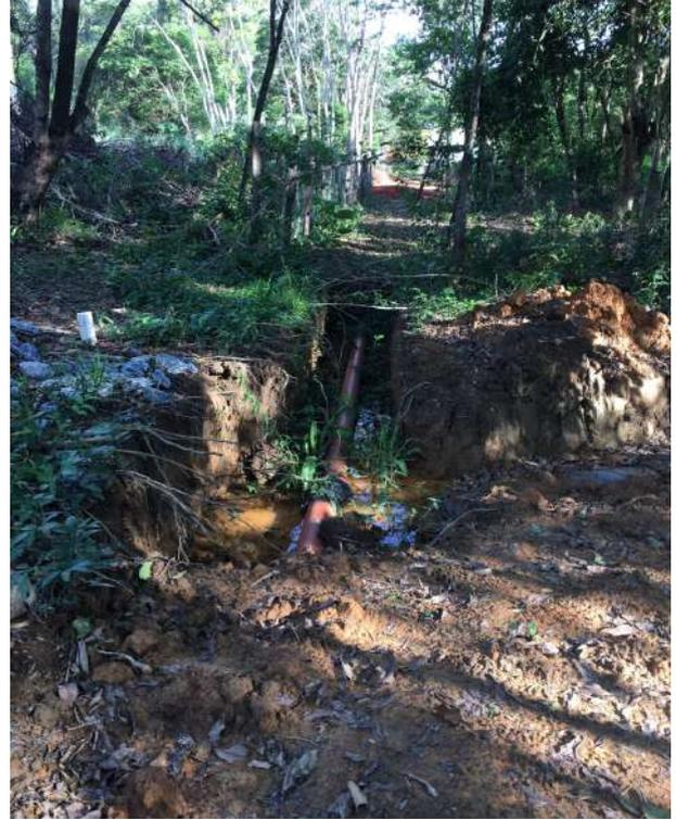
**Fotos 09 e 10:** Poço de visita da rede de esgoto, a ser implantado no ponto mais baixo.
