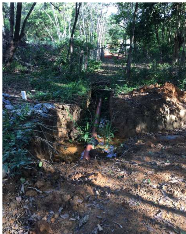
Fotos 09 e 10: Poço de visita da rede de esgoto, a ser implantado no ponto mais baixo.
