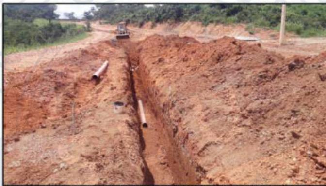
**Figura 4** – Detalhamento da implantação da rede de água do Loteamento Parque das Borboletas. Fonte: Processo 1611-22-LST-LIC
