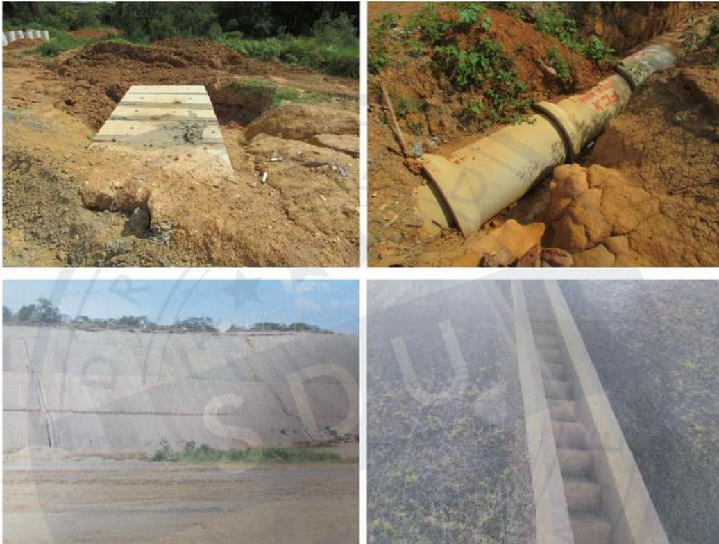
**Imagem 5.** Demonstração das obras e infraestrutura de drenagem implantada na área do empreendimento. Fonte: Arquivo DMA.
