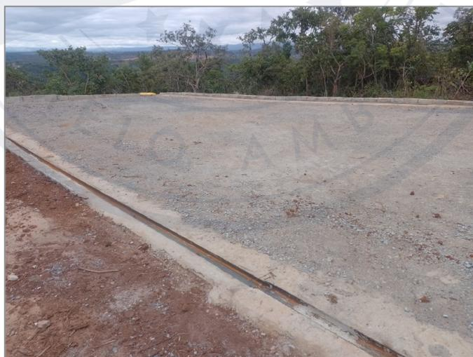
**Figura 05** – Pátio pavimentado, com destaque para a canaleta de contenção e caixa SAO ao fundo. Fonte: Arquivo DMA.
