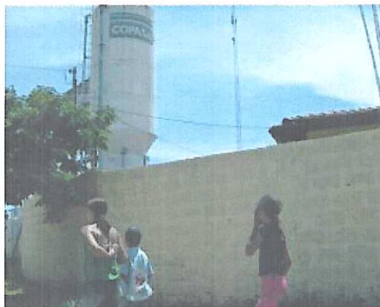
Figura 04: Reservatório Morro do Cruzeiro
