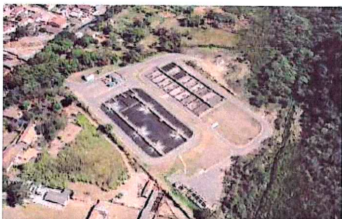
Figura 15: Vista Aérea da ETE Central
