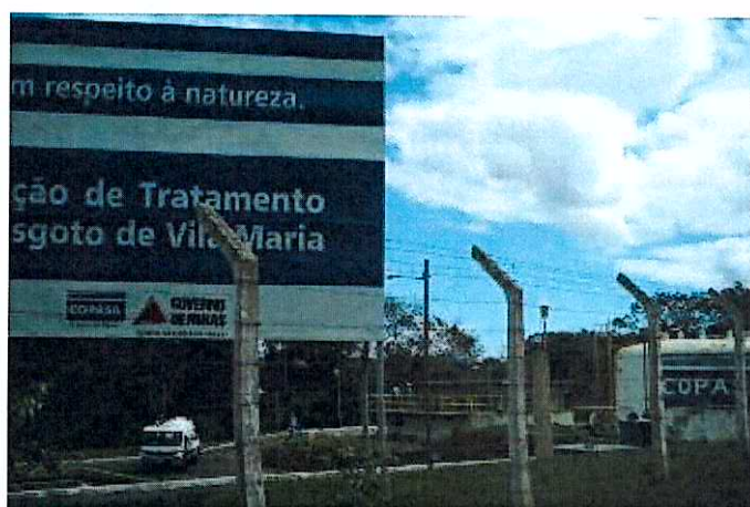
Figura 16: Vista da ETE Vila Maria
